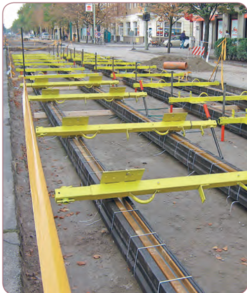
Villamospálya felújítása Szegeden
