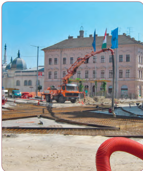
Intelligens közlekedési csomópont építése
